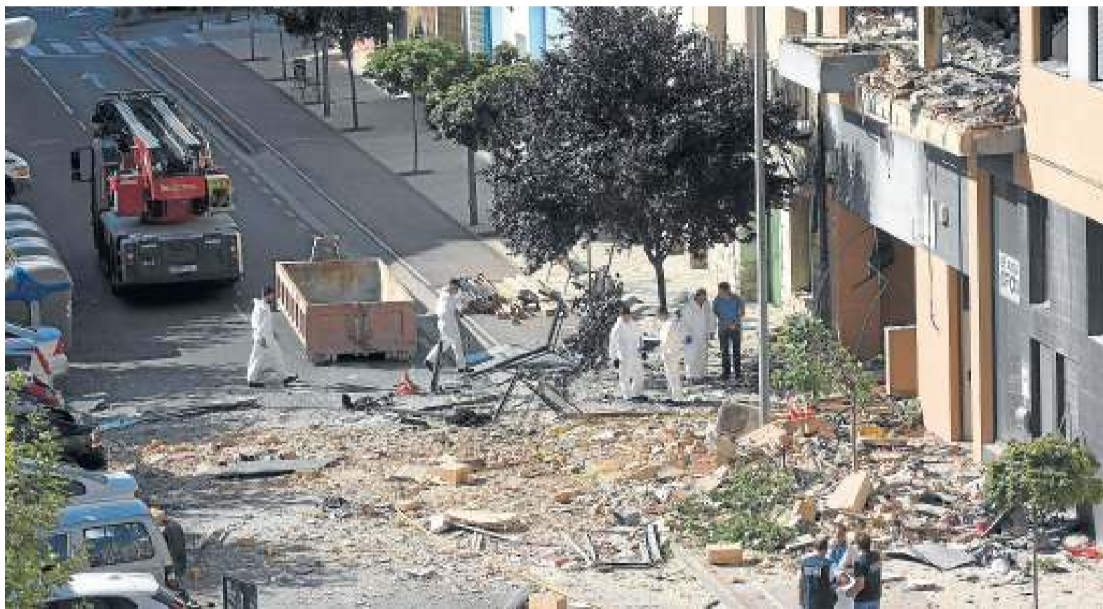
La fachada principal de la vivienda se desplomó en la calle tras la explosión, provocando daños a cinco vehículos. Foto: Efe
