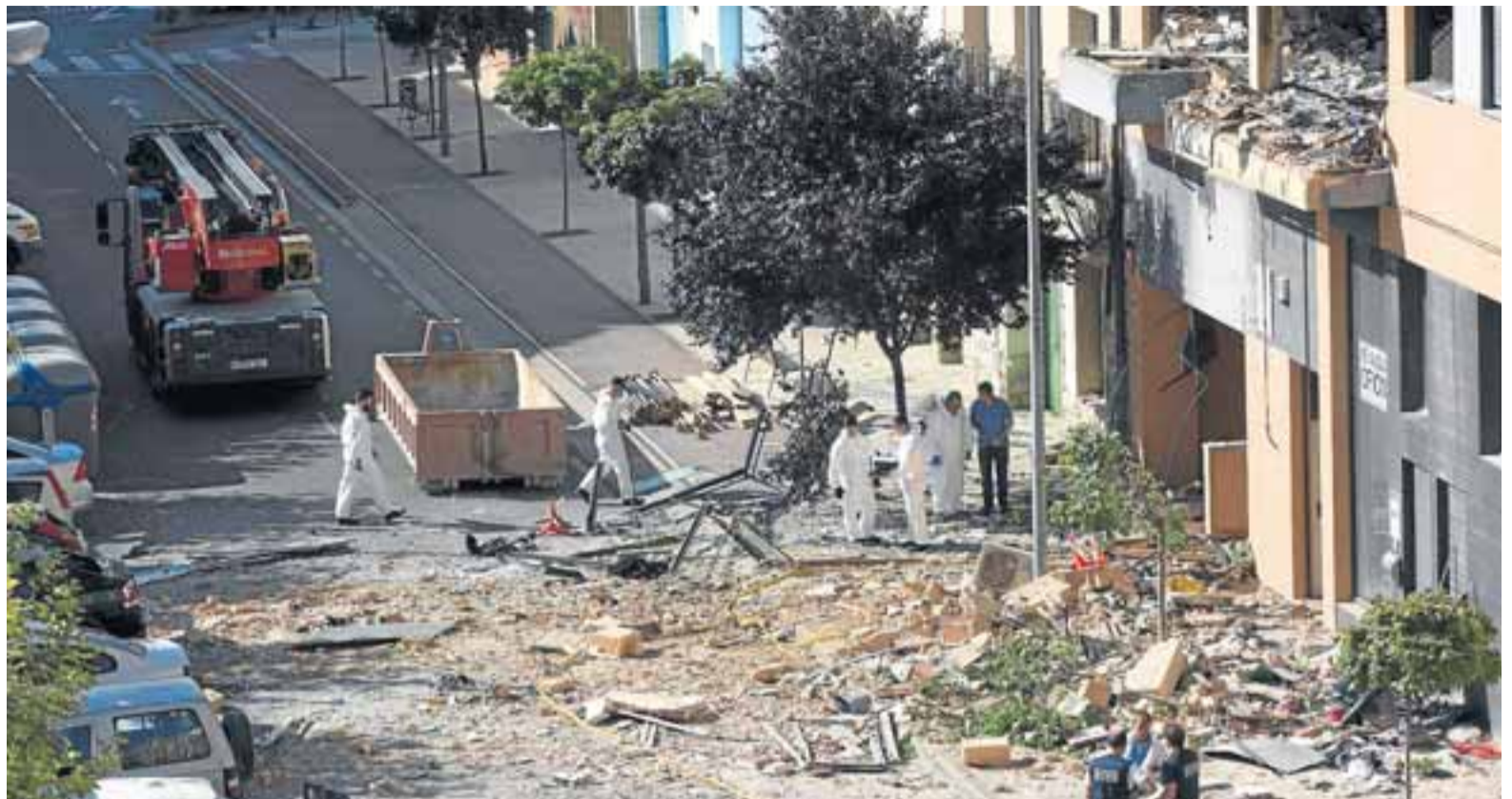
La fachada principal de la vivienda se desplomó en la calle tras la explosión, provocando daños a cinco vehículos. Foto: Efe
